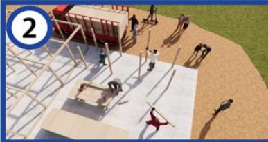
2 環境配慮型グリーンハウス (コンセプトモデル) 滋賀県産材やリユースの単管パイプ等を使って環境に配慮したグリーンハウスを設置する。
